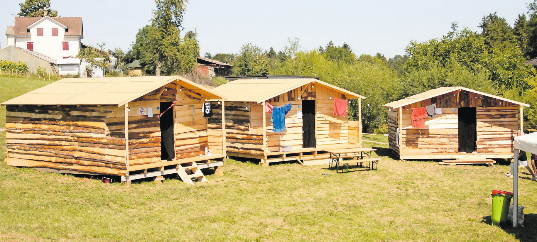
Insgesamt 15 solcher Hütten haben die rund 130 Teilnehmenden an einem Tag aufgebaut.
