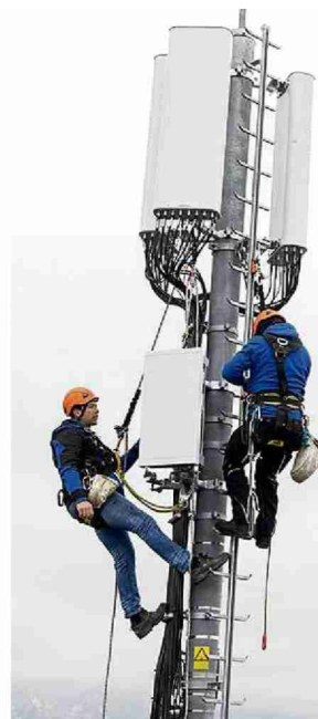
Aufbau einer 5G-Antenne. KEY
