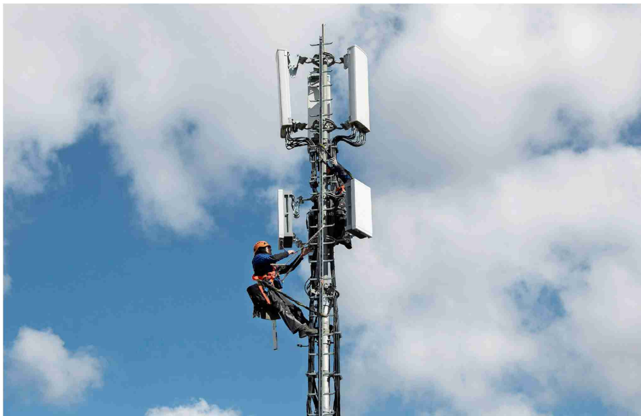
Installation einer 5G-Antenne in Bern: Die gesundheitlichen Risiken sind überschaubar
